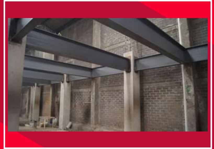
Elementos estructurales con menor huella de carbono
